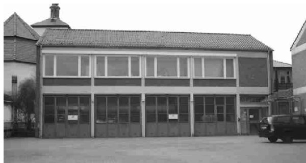
Das ehemalige Feuerwehrgerätehaus wird umgebaut.
